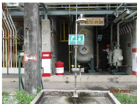
ภาพที่ 2-28 ฝักบัวฉุกเฉินและที่ล้างตาฉุกเฉิน
