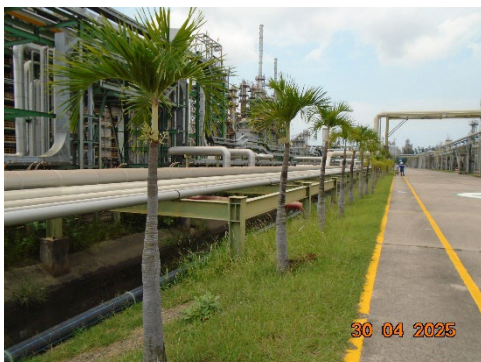
ภาพที่ 2-32 ท่อรับน้ำดิบเพลิงจากบริษัท พีทีที โกลบอล เคมิคอล จำกัด (มหาชน)
