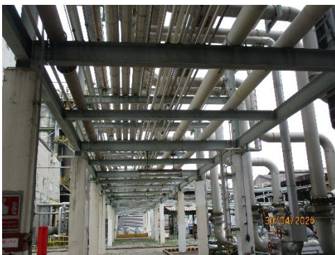
ภาพที่ 2-23 การติดตั้งท่อขนส่งบนฐานรองรับเหนือพื้น
