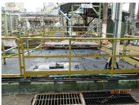
ภาพที่ 2-7 บ่อ Oil-Waste Separator
